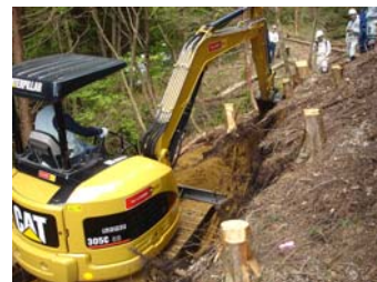
技術者養成研修：作業路作設実習
